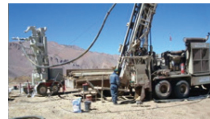
ドリルで穴をあけて地下を調査
