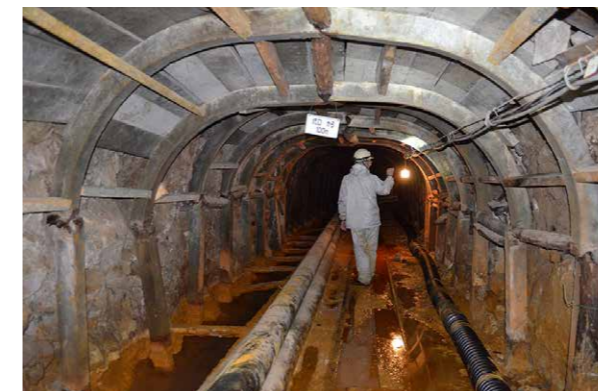
坑道点検 (花輪鉱山)
