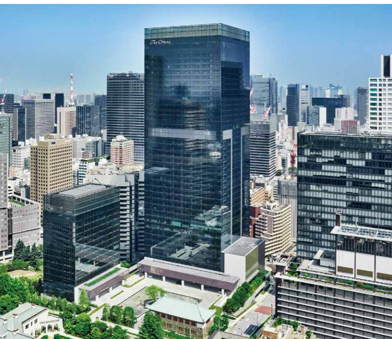
中央が新本社(オークラプレステージタワー)
