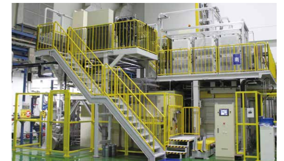
半導体用スパッタリングターゲットの設備、溶解炉(磯原工場)
