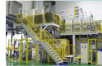
半導体用ターゲット生産設備の増強(磯原工場)
