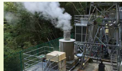
温泉熱を利用したバイナリー発電装置(下田温泉)
