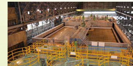
豊羽鉱山(北海道)の本山坑廃水処理場の様子
