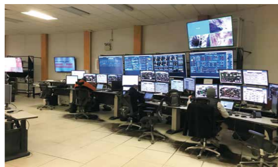
カセロネス銅鉱山の高度制御プログラム
