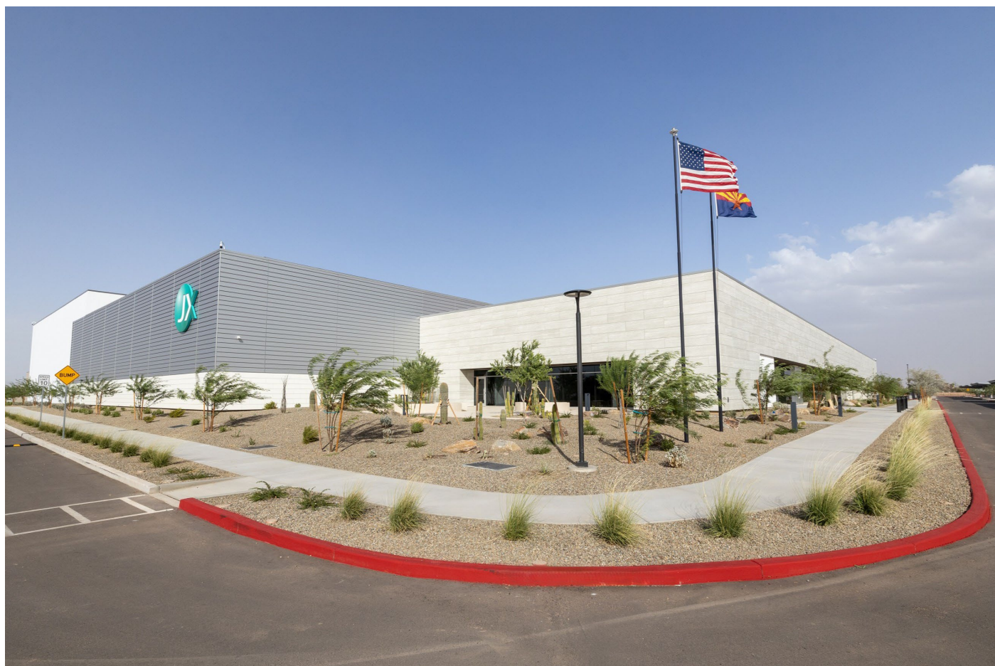
新工場外観写真
