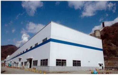
(7月に完成したHMC工場（第1期）建屋)
