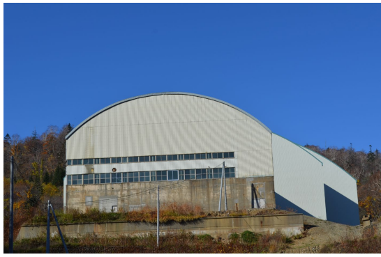
坑水处理設備建屋外觀
