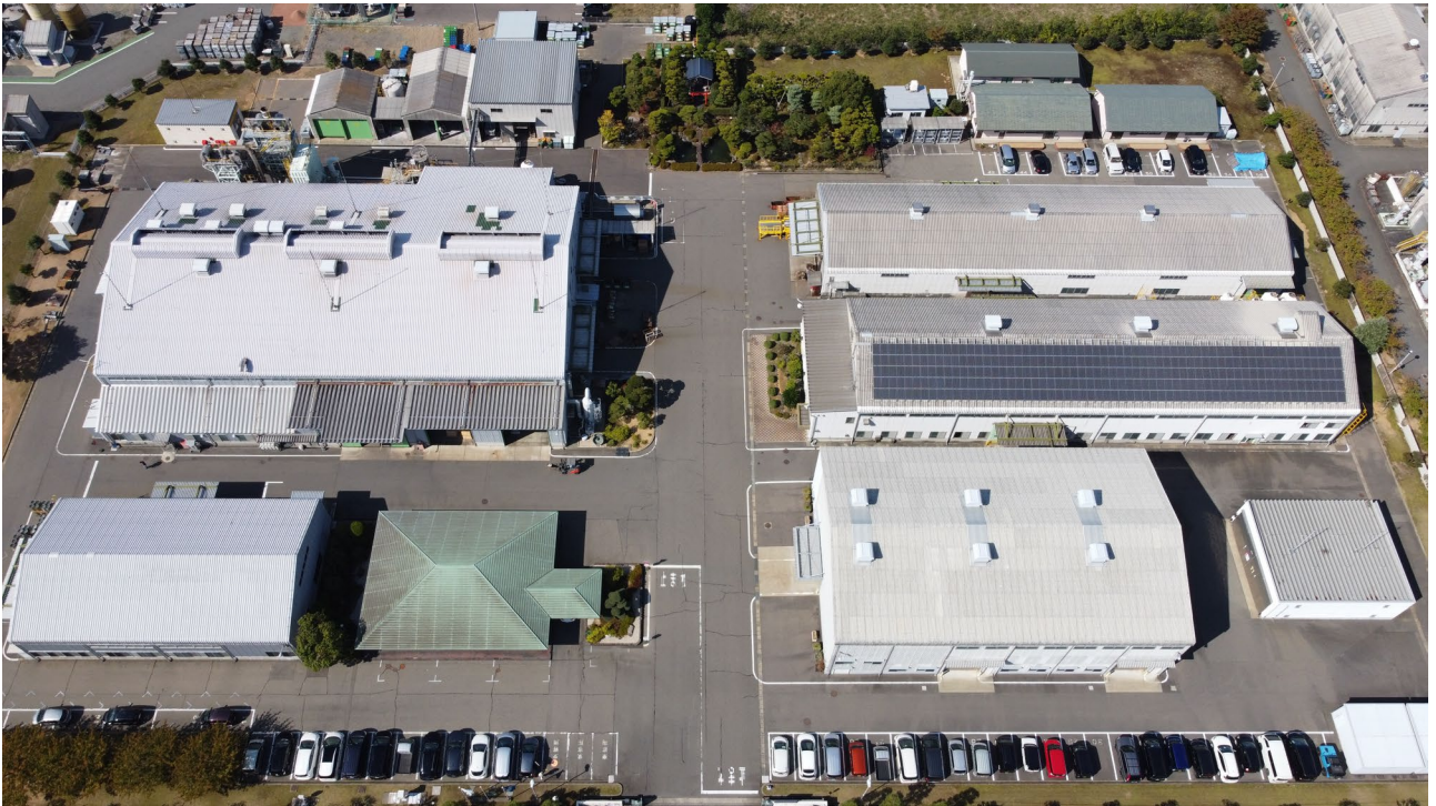
大阪合金 本社工場全景
