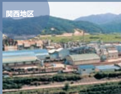
日鉱敦賀リサイクル(株)(福井県敦賀市)
