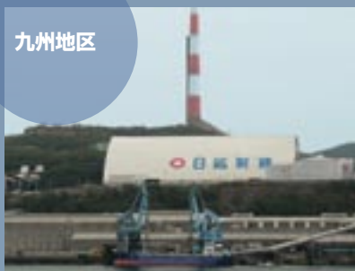
日鉱製錬(株)佐賀関製錬所(大分県大分市) 佐賀関製錬所においては、年間約10万トンのリサイクル原料を処理しており、アジア地域で最大級の銅・貴金属リサイクル拠点となっています。
