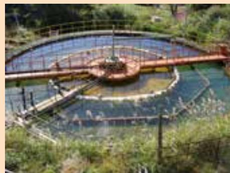
澱物層濾過を適用した水処理施設（大谷鉱山の固液分離槽）
