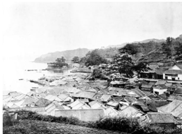
大煙突建設当時の佐賀関の町並み
