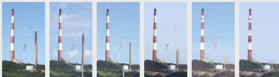
第一大煙突の解体の様子
