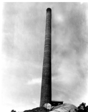
日立と同じ鉄筋コンクリート造りの関の大煙突
