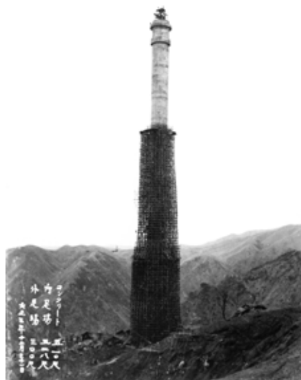
当時では珍しい鉄筋コンクリート造りの日立の煙突
