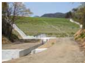
竣工した菅刈堆積場
