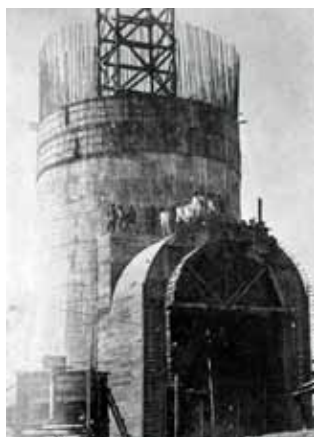
建設中の関の大煙突
