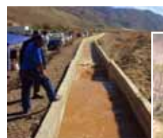
強化コンクリートで補修された用水路
