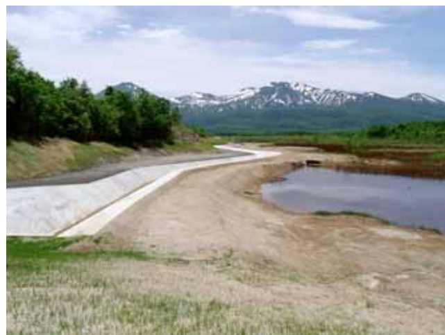
豪雨対策工事を行った上北鉱山田代平第一堆積場
