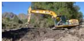
コピアポ川河床の整備
