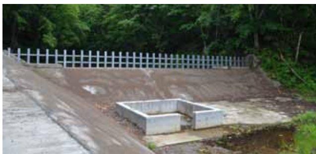
豪雨対策工事を行った花輪鉱山 田の沢堆積場 （上）堆積場のかん止堤と非常用排水路 （下）豪雨時の流木をせき止める流木止め
