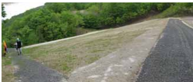
地震対策工事を行った上北鉱山 下の沢堆積場
