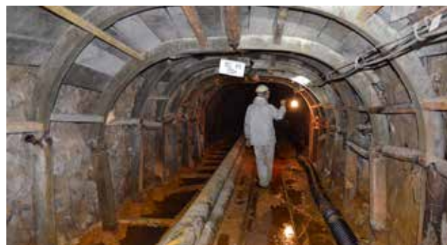
坑道点検（花輪鉱山）
