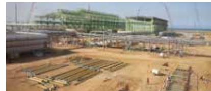
現地の建設風景
