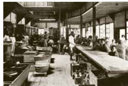
日立鉱山の供給所
