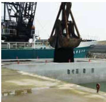
ケーソンへのスラグ投入作業
