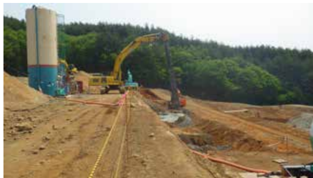
地震対策工事の様子（大谷鉱山）
