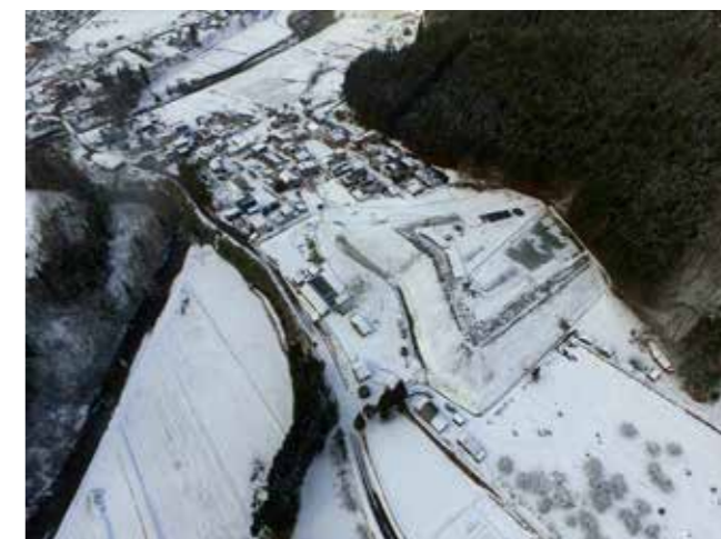
鉛山鉱山 大湯第1第2堆積場(地震対策工事)
