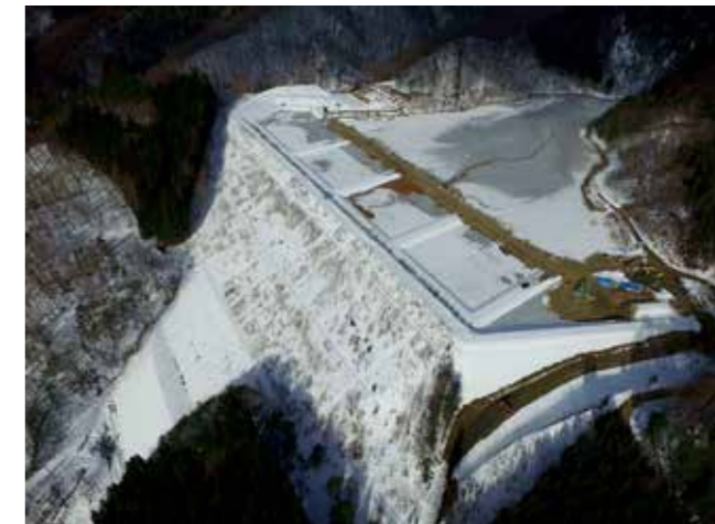
花輪鉱山 中ノ沢堆積場(地震対策工事)
