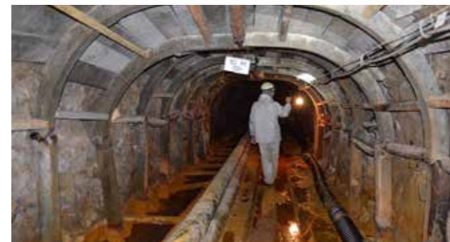
坑道点検(花輪鉱山)
