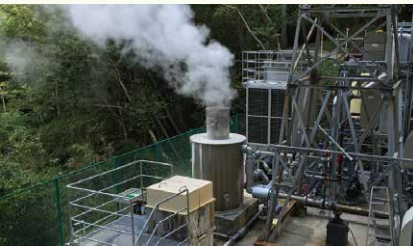
温泉熱を利用したバイナリー発電装置(下田温泉)
