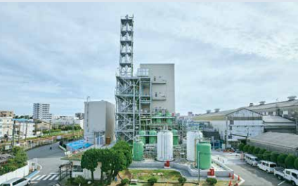
茅ヶ崎工場(神奈川県)の触媒新工場
