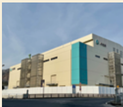
仕上圧延工場
