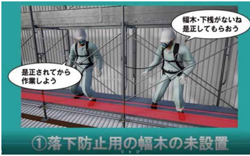
高所からの転落事例
