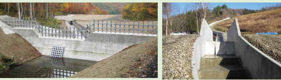
対策工事の例：砂防堰堤（流木止め）の設置 対策工事の例：排水路の整備
