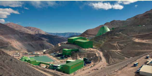
カセロネス銅鉱山（2021年1月にCO 2 フリー電力に切り替え）
