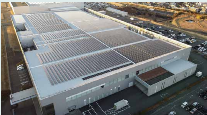
掛川工場屋上に設置した太陽光発電設備
