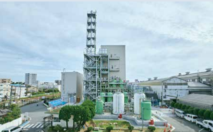
茅ヶ崎工場(神奈川県)の触媒新工場
